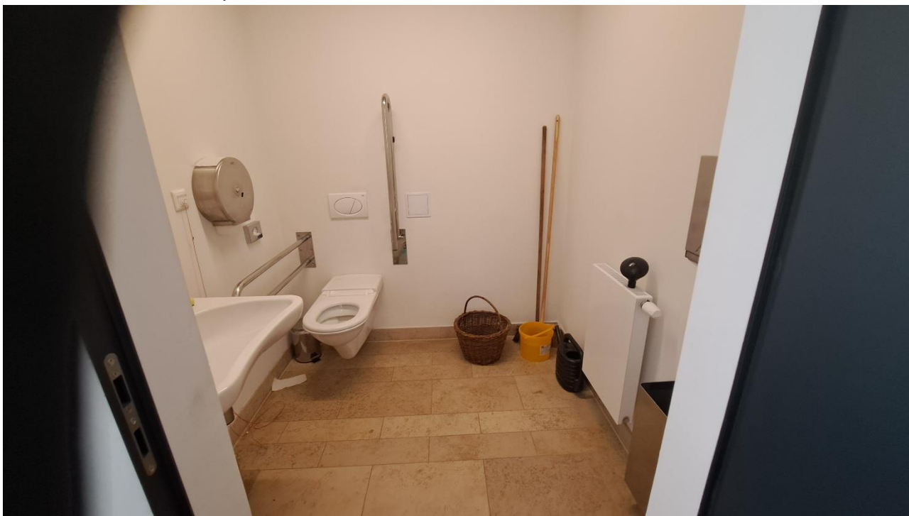
Foto - detail bezbariérové toalety
