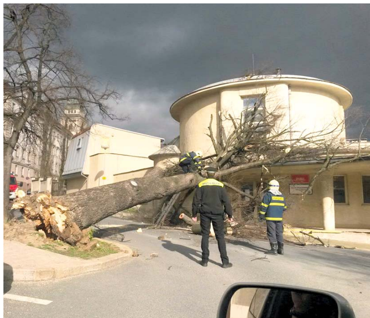
■ Na Dyjské ulici vyvrátil vítr vzrostlou lípu, která v pádu poškodila přes silnici stojící budovu léčebny dlouhodobě nemocných. K odstranění stromu byli přivoláni hasiči, a později také Městská zeleň, aby pořezané kusy stromu odvezla. Foto:Lukáš Křenečský
