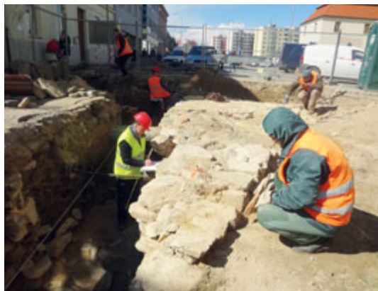
■ Základy severní věže.
