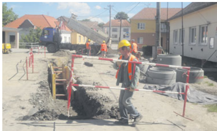
■ Výstavba kanalizace v Mramotících.
